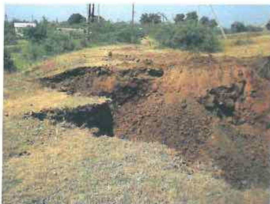
Jalkoti: A collapsed road section
