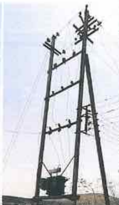
Anjad Barda: Missing LA
